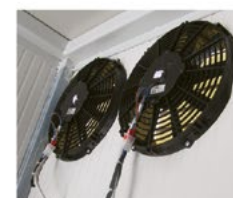
Ventola estrazione aria Fan air expulsion
